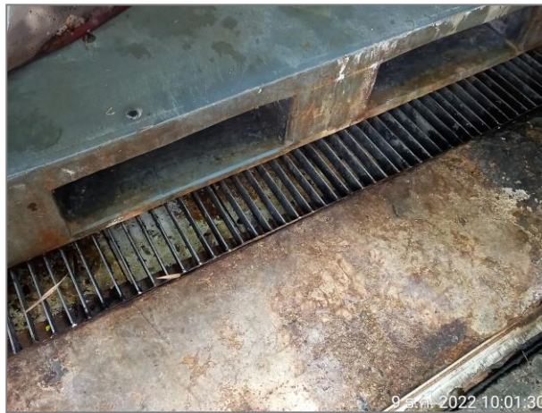
รูปที่ 2.32 ท่อระบายน้ำเสียในห้องพักขยะ
